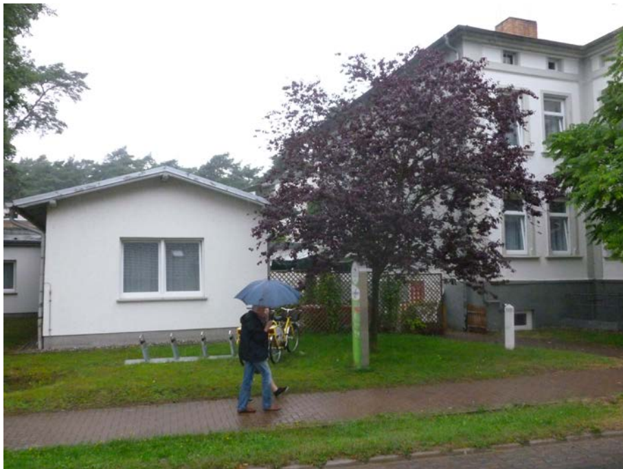
Foto 2 Jägerstraße Haus Nordlicht mit Anbau
