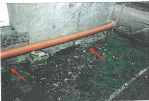
schadhafter Sockelbereich
