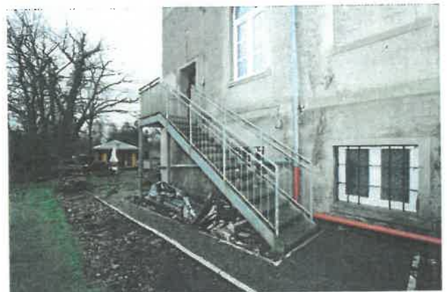
Außentreppe an dieser Gebäudeseite
